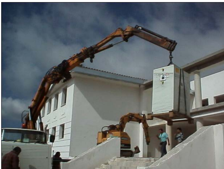
Σχήμα 2.7: Ευρωπαϊκό Κέντρο Δημοσίου Δικαίου, άποψη του κτιρίου κατά τη διάρκεια των έργων (Καρύτσας και Μενδρινός, 2005).
