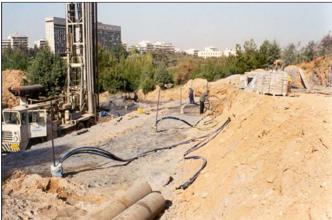
Σχήμα 2.12: Κτίριο Μεταλλειολόγων, κατακόρυφοι εναλλάκτες θερμότητας εδάφους κατά τη διάρκεια της κατασκευής (Καρύτσας και Μενδρινός, 2005).
