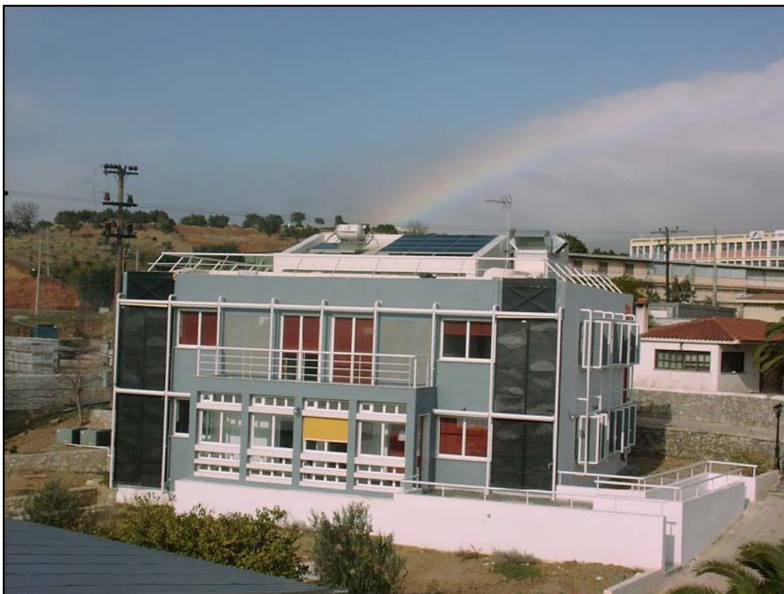
Σχήμα 2.9: Άποψη του κτιρίου γραφείων του ΚΑΠΕ (Καρύτσας και Μενδρινός, 2005).
