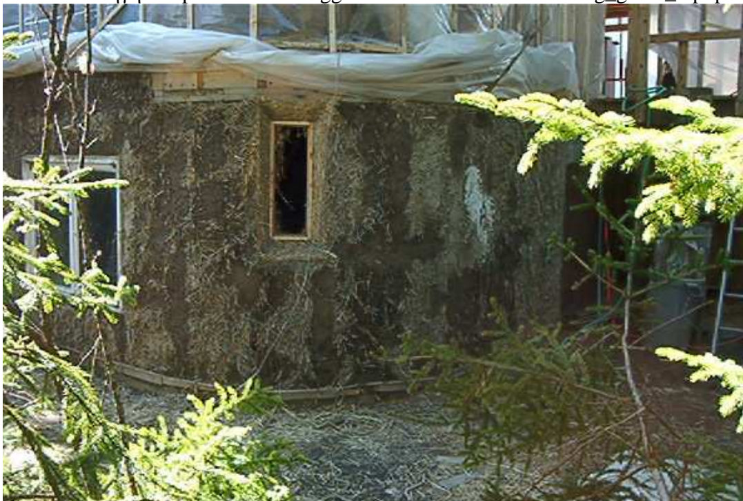
Εικόνα 32 Ξύλινος σκελετός με τοίχους πλήρωσης από αχυρόμαπαλες και επίχρισμα πηλού.
