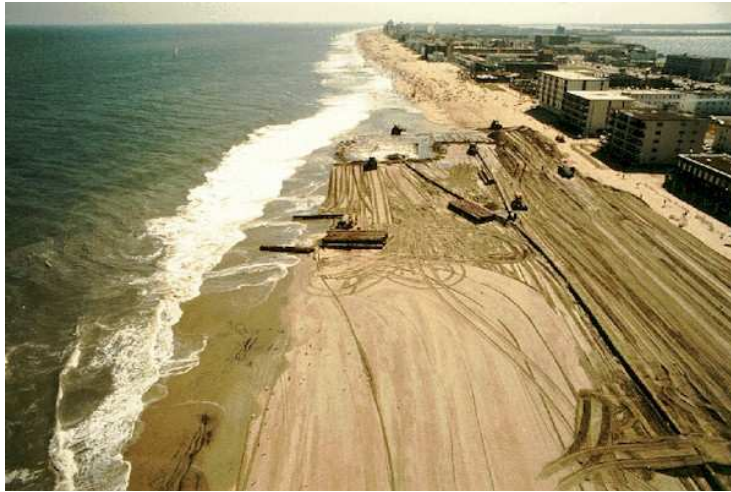
Σχήμα 3. Τεχνητή Αναπλήρωση: τροφοδοσία με υγρό θαλάσσιο ίζημα που αδειάζεται πάνω στην ακτή και στη συνέχεια διαβαθμίζεται σύμφωνα με τον προβλεπόμενο σχεδιασμό για τις ιδιαιτερότητες της κατασκευής.
