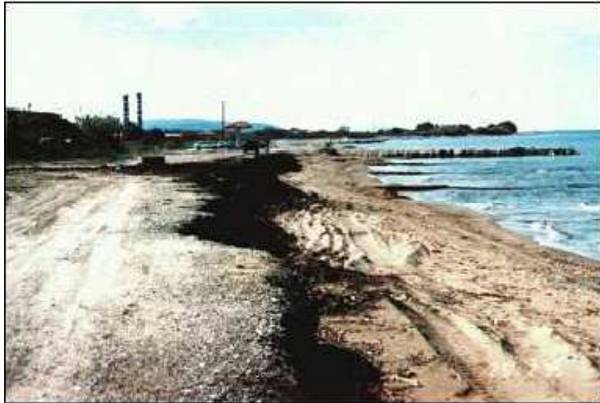
Σχήμα 8. Εφαρμογή της μεθόδου σε ακτή της Ν. Ρόδου. Στο βάθος διακρίνεται κατασκευή έξαλλου προβόλου ογκολίθων εγκάρσια προς την ακτή που δημιούργησε έντονη διάβρωση στην ακτή. Παρότι η κατασκευή δεν καθαιρέθηκε, η μεταγενέστερη εφαρμογή της μεθόδου των πυθμενικών προβόλων σε ενδιάμεσο τμήμα της ακτής είχε ως αποτέλεσμα την διακοπή της διάβρωσης και την σταδιακή συσσώρευση φυσικού υλικού.
