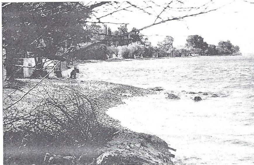
Φωτογραφία 25,26,27: Κρήνα στο κεντρικό τμήμα της παραλίας Βαλιμίτικων 21.01.2000, Διάβρωση ακτής στο δυτικό άκρο της παραλίας Βαλιμίτικων (διακρίνεται η υποσκαφή του τοιχίου της παραλιακής οικίας 18.04.2002, Δυτικό άκρο της παραλίας Βαλιμίτικων, η παραλία έχει μικρό εύρος και ο πρόχειρα κατασκευασμένος πρόβολος έχει καταστραφεί 18.04.2002
