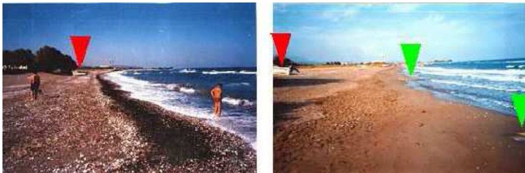
Σχήμα 9. Παράδειγμα εφαρμογής της μεθόδου με αύξηση του πλάτους της ακτής σε διάστημα μερικών μηνών. Με πράσινα βέλη σημειώνονται τα ίχνη κάποιων πυθμενικών προβόλων στην ακτογραμμή καθώς οι περισσότεροι καλύφθηκαν με φερτά υλικά που συσσωρεύτηκαν από την λειτουργία του συστήματος, χωρίς τεχνητή αναπλήρωση.
