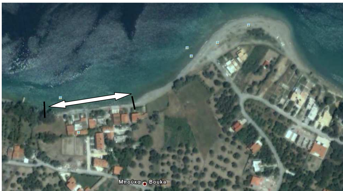
Εικόνα 14: Περιοχή διάβρωσης στις Καμάρες Ερινεού
