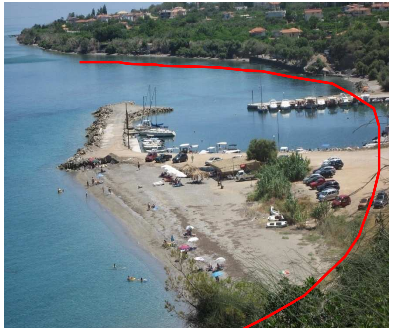
Φωτογραφίες 1 και 2: Παράδειγμα κακού σχεδιασμού παράκτιας κατασκευής (αλιευτικό καταφύγιο-ανατολική λήψη) στην περιοχή Κρυονέρι Ακράτας (Ιούνιος 2010 Με κόκκινο απεικονίζεται η ακτογραμμή πριν την κατασκευή του καταφυγίου)
