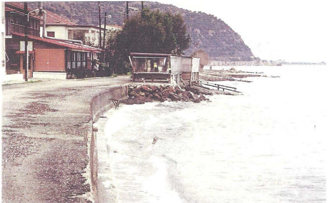
Φωτογραφία 15: Ανάκλαση των κυμάτων στο κατακόρυφο τοίχιο. 17.01.2001
