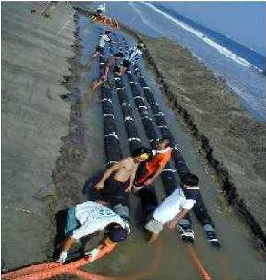
Εικόνα 5. Πειραματική Εφαρμογή που έγινε την περίοδο 1999-2000 στην ακτή Shibushi της πόλης Kagoshima, Ιαπωνία (σύστημα αποστράγγισης με την χρήση αντλιών).
