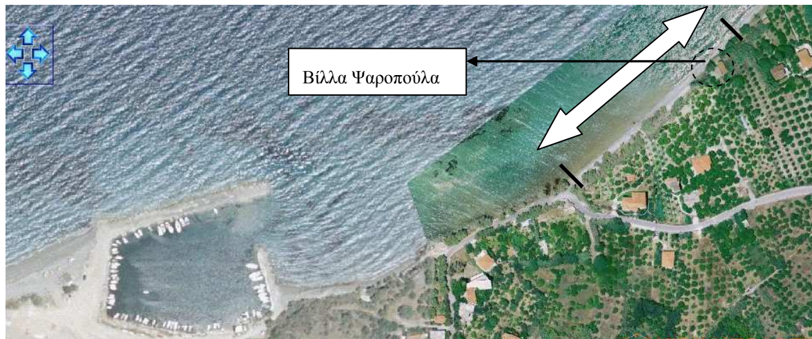
Εικόνα 8: Περιοχή κατασκευής πρανούς προστασίας 250 m στο Κρουονέρι Ακράτας
