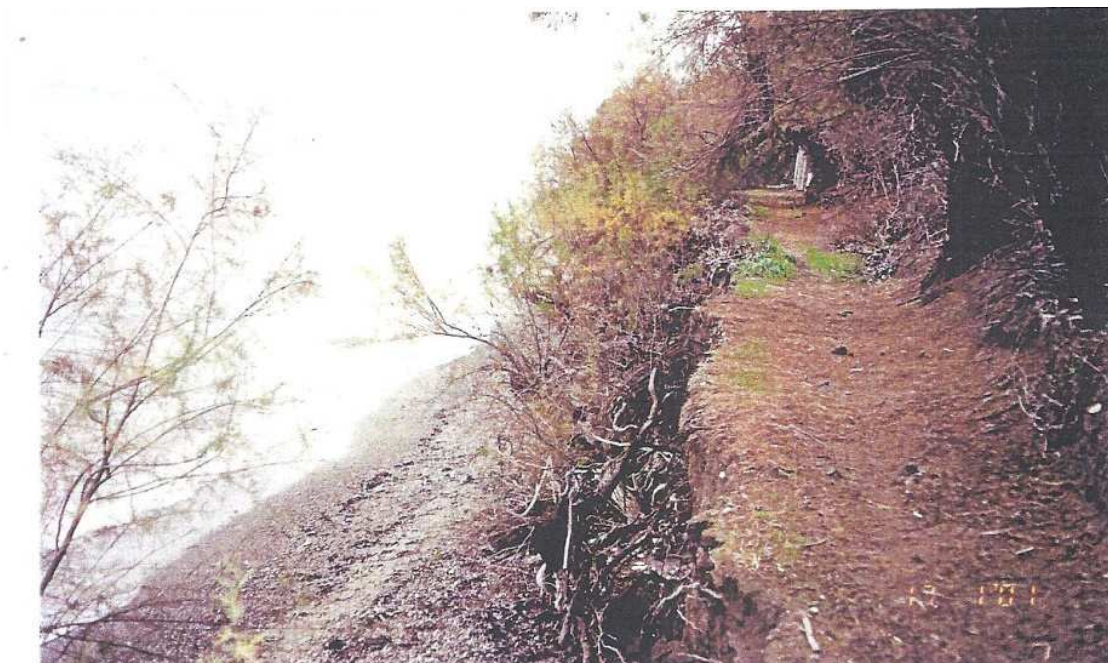
Φωτογραφία 12: Αναβαθμός 2m και ξεριζωμένα δέντρα λόγω της διάβρωσης στο δυτικό τμήμα της Παραλίας Κρυονερίου 17.01.2001
