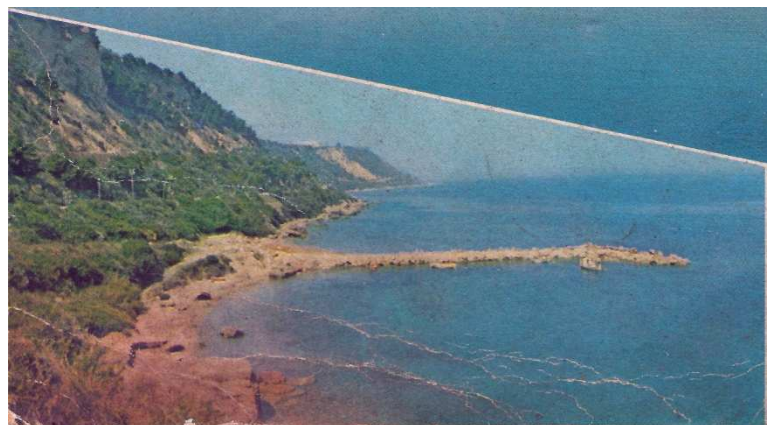
Φωτογραφία 4: Το αλιευτικό καταφύγιο 1981 (δυτική άποψη)
