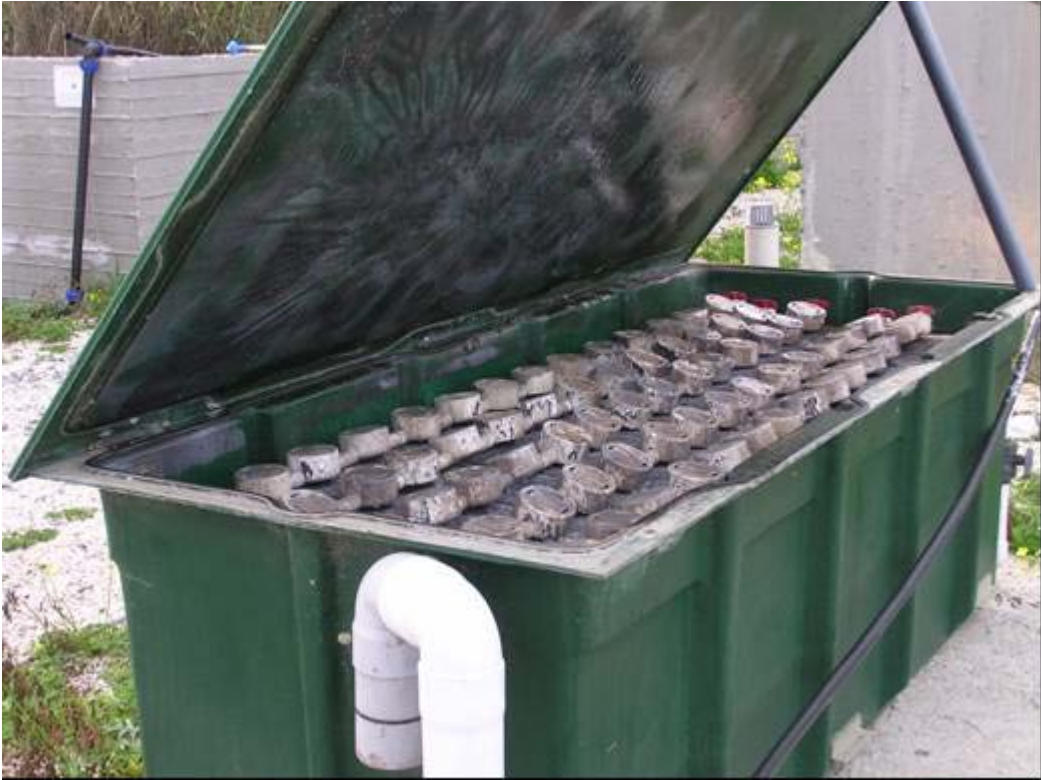
Εικόνα 5. Σύστημα βιολογικής επεξεργασίας με τεχνολογία προσκολλημένης βιομάζας Advantex.
