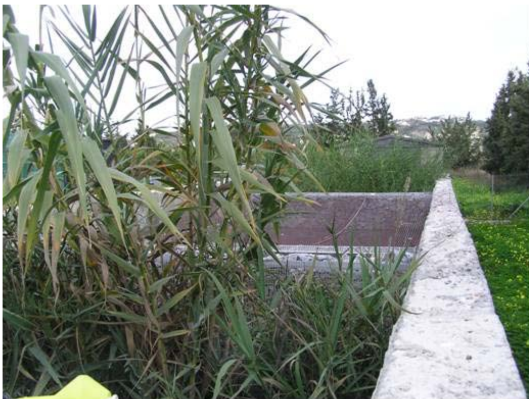
Εικόνα 3. Υγροβιότοπος ελεύθερης επιφανείας (FWS) με ενδιάμεση ανοξική ζώνη
