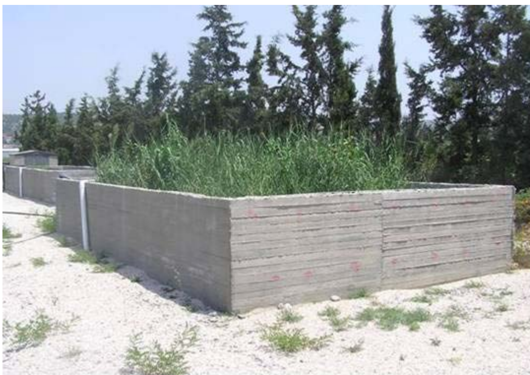
Εικόνα 4. Υγροβιότοπος υποεπιφανειακής ροής (SSF).
