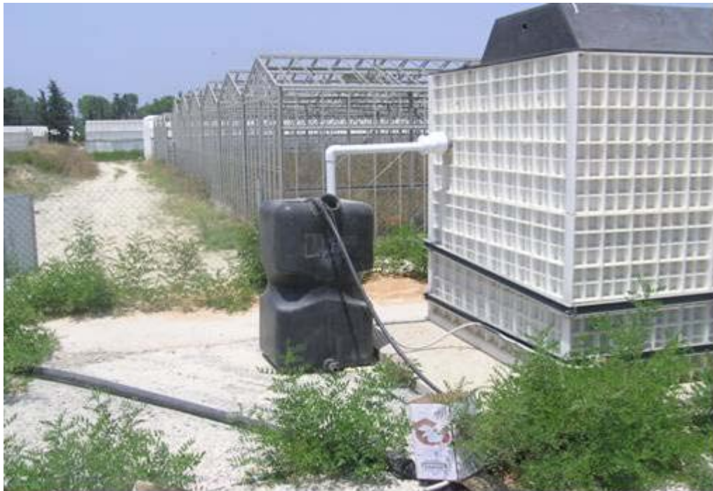
Εικόνα 6. Σύστημα βιολογικής επεξεργασίας με τεχνολογία βιοδίσκων EKOL.
